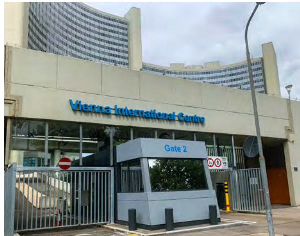
Puesto de control recientemente construido en la puerta de acceso 2 al CIV
