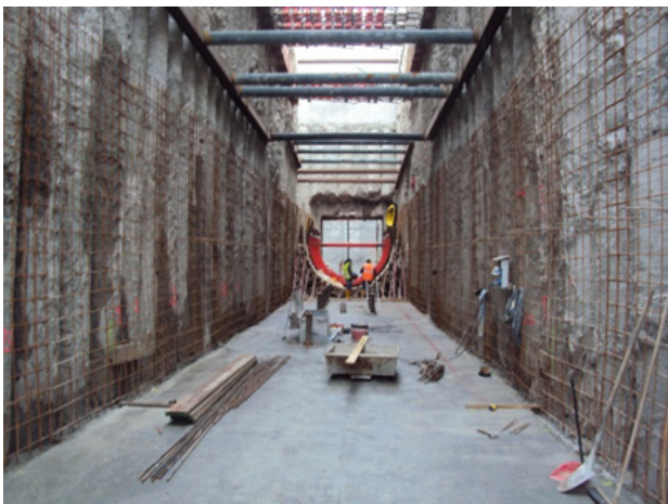
(d) formwork of the lower semicircle
